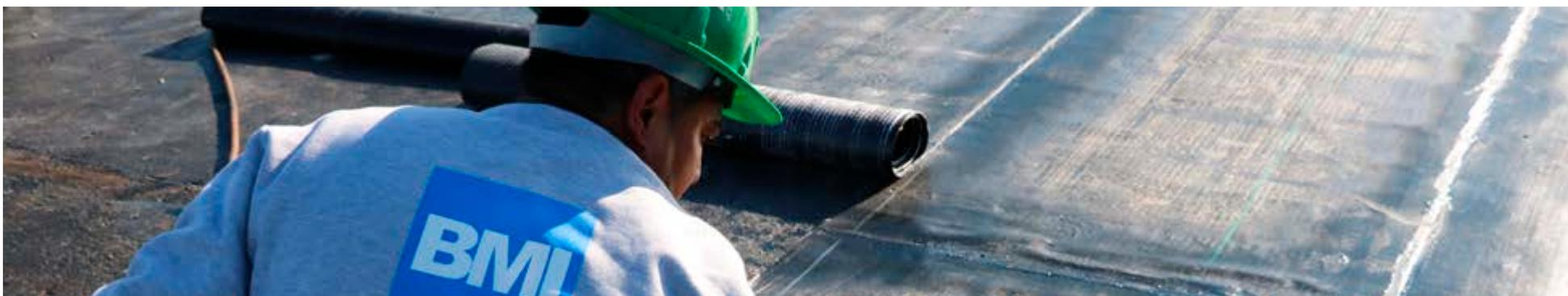
Láminas asfálticas de impermeabilización de betún oxidado, de 3 o de 4 kg/m<sup>2</sup> de masa, reforzadas con una armadura de velo de vidrio o de poliéster no tejido.
