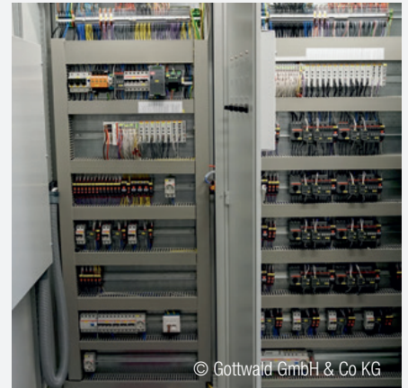
Automationsverteiler für Heizkreisgruppen. Automation components for heating circuit groups.
